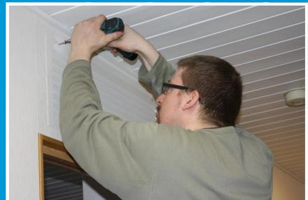
Säleiköt kiinnitetään paikoilleen ja asennus on valmis. Säleikkö asennetaan siten että ilmavirtaus on katteen pään. Mikäli väliseinä ei pidetä auki, tulee väliseinään tai oveen asentaa siirtoilmasäleikkö.
