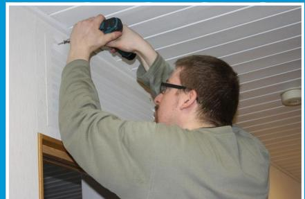
Gallren fästs på plats och installationen är färdig. Gallret installeras så att luftflödet riktas mot taket. Om innerdörren inte hålls öppen bör man installera ett luftgaller i mellanväggen eller i dörren.
