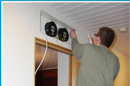
Efter att utrustningen är installerad i öppningen så tätas mellanrummet mellan väggelementet och genomföringsskanalen. Luftrikningen skall vara mot det rum som skall värmas / avkylas.
