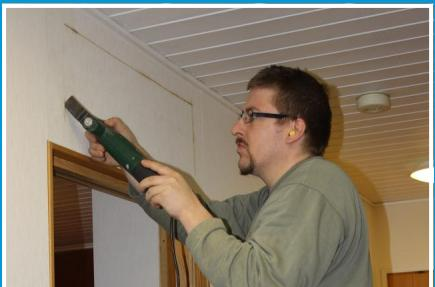
Oven yläpuolelle tehdään 550 x 215 mm kokoinen aukko. Sen voi tehdä myös muualle kuin oven yläpuolelle, mutta mielellään seinän yläosaan.
